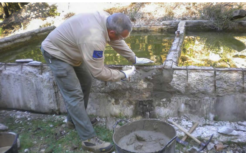
Restauración del abrevadero en la Microrreserva de Flora Font del Teixet (Morella, Castellón). ARCHIVO BN2000.
