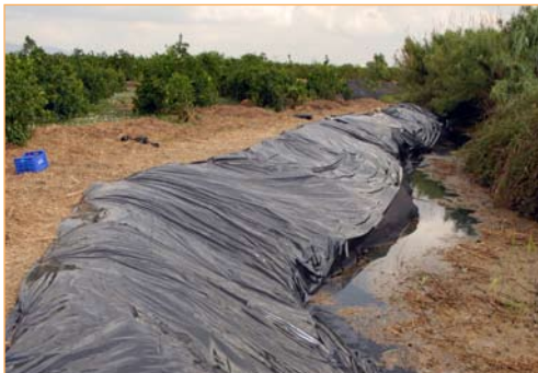
Figura 10. Cubrimiento con geotextiles recubiertos de plástico
