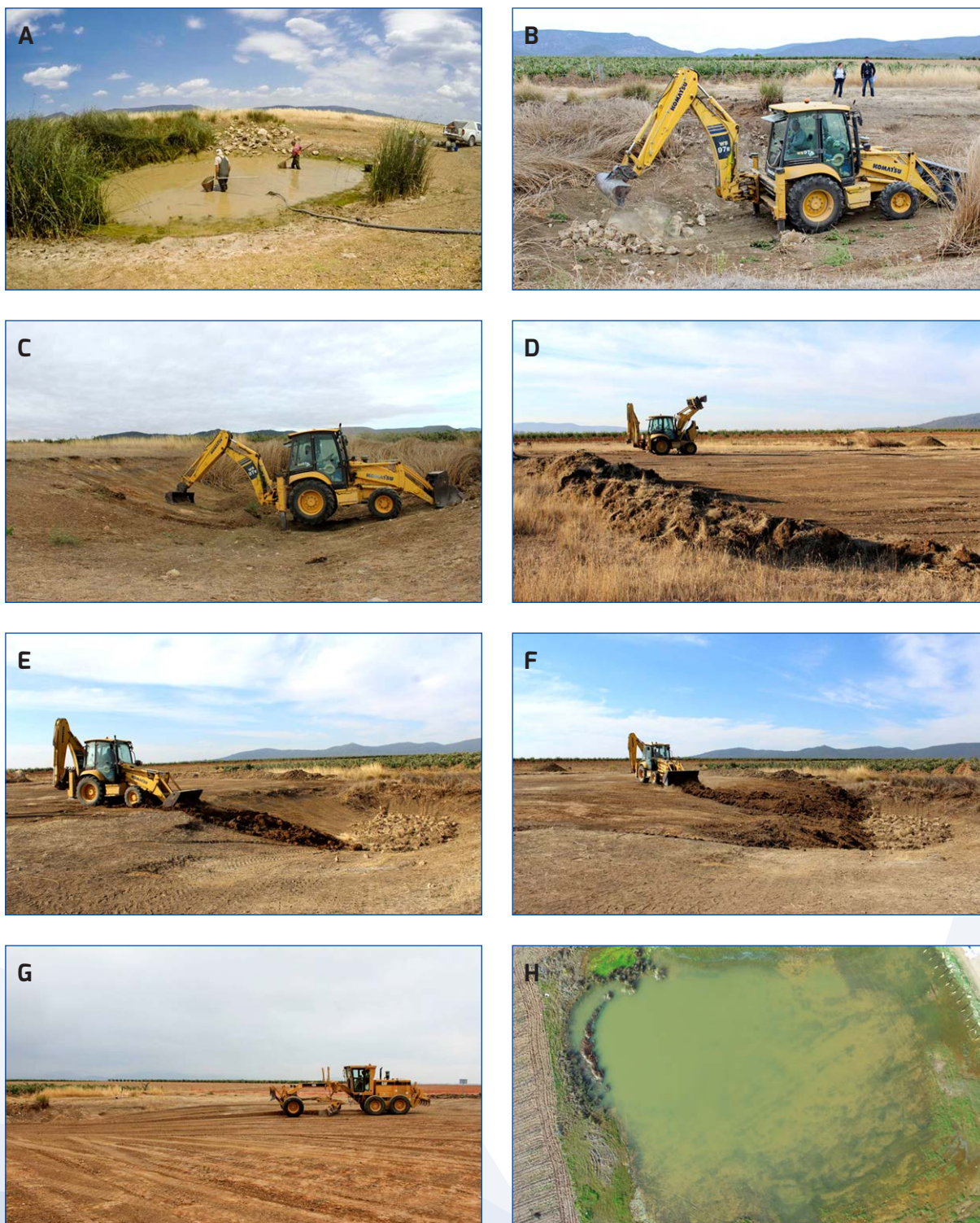
Figura 7. Trabajos de reperfilado del Lavajo del Tío Bernardo. A) Vaciado e la cubeta y recuperación de fauna. B) Acopio de elementos sólidos en el fondo de la cubeta. C y D) Recuperación de la capa superficial de sedimentos con vistas a su salvaguarda y posterior redistribución. E y F) Rellenado G) Reperfilado y nivelado H) Resultado de los trabajos donde se observa el incremento del área de inundación (Imagen drone del 14.02.2017). Fotografías de Ramón G. Pereira.
