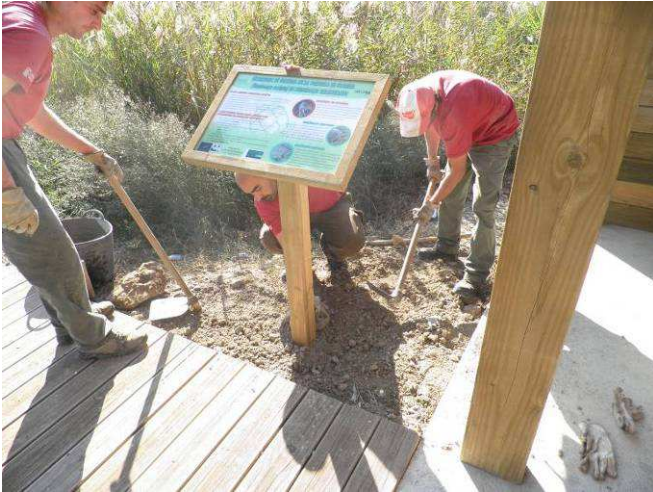
Figura 27: Instalación de un cartel divulgativo en una de las áreas de trabajo (marjal de Almenara).
