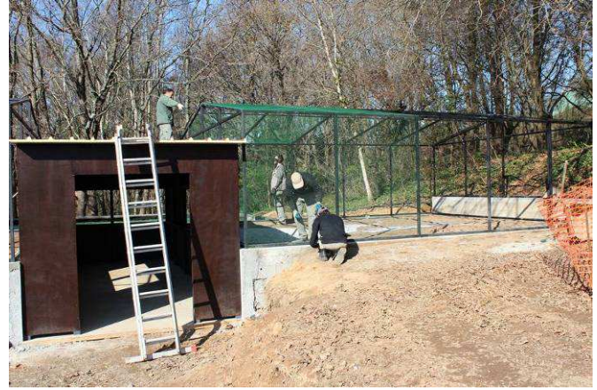
Figura 20: Balsa de aclimatación en el Parque Biológico de Gaia.
