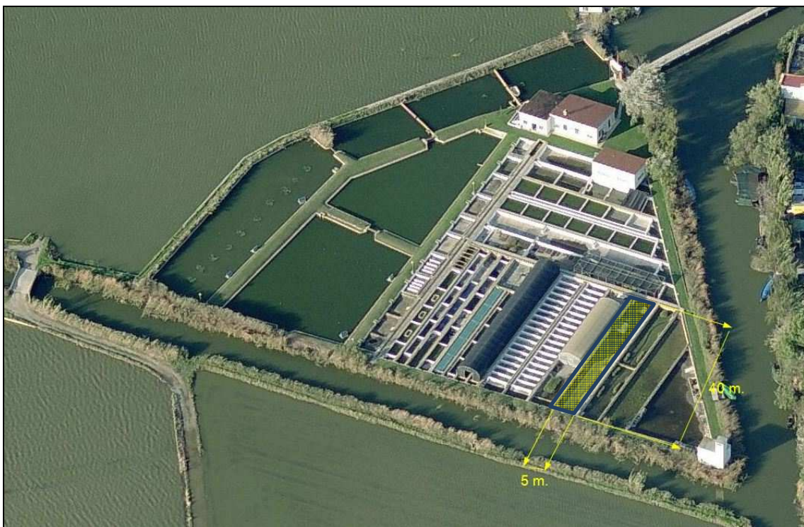
Figura 1: Vista aérea de las instalaciones del C.I.P., en amarillo se acota la balsa de E. orbicularis .
