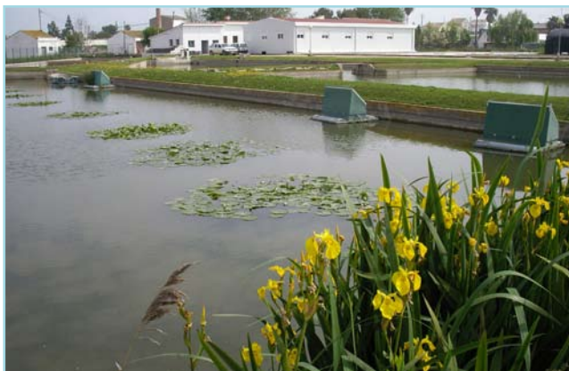
Vista general de las instalaciones del CIP
