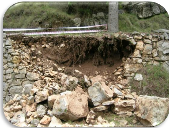
Fotos 8 y 9: reconstrucción de un muro de piedra en seco en el Forn del Vidre
