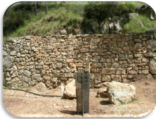
Fotos 8 y 9: reconstrucción de un muro de piedra en seco en el Forn del Vidre
