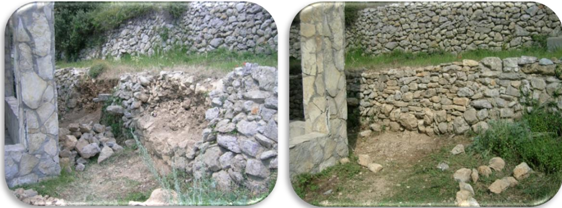
Fotos 5 y 6: reconstrucción de un muro de piedra en seco en el Mas de Boix Fuente: archivo fotográfico del PN
