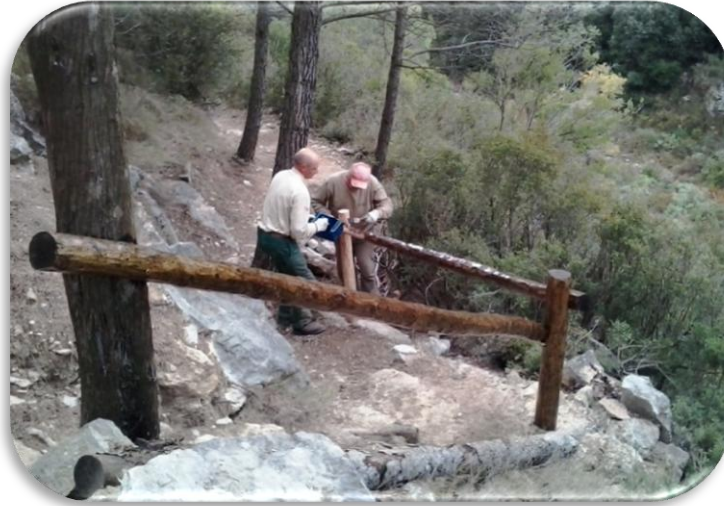
Foto 4: colocación de barandillas en la ruta azul del PN Fuente: archivo fotográfico del PN
