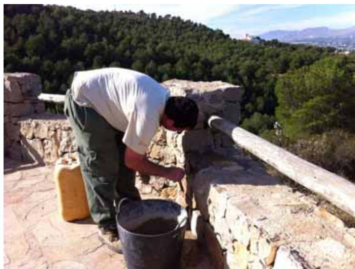
Figura 62. Construcción de vallado de seguridad en el acceso a uno de los miradores de la ruta del Faro del Albir (L'Alfàs del Pi) Fuente: Archivo fotográfico del Parc Natural de la Serra Gelada
