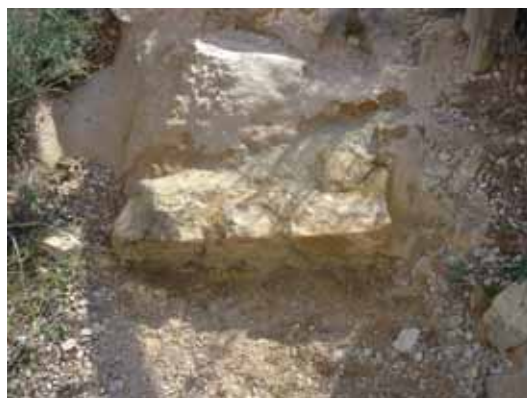
Figura 59. Construcción de diferentes escalones y peldaños en distintas rutas Fuente: Archivo fotográfico del Parc Natural de la Serra Gelada.
