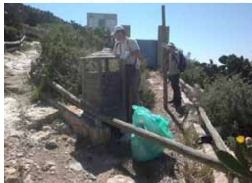
Figura 27. Reparando el murete de la senda de l'Illa Fuente: Archivo fotográfico del Parc Natural de la Serra Gelada
