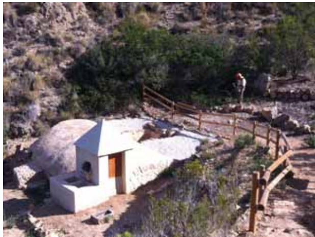
Figura 12. Actuaciones de desbroce realizadas en los antiguos bancales del aljibe del Faro
