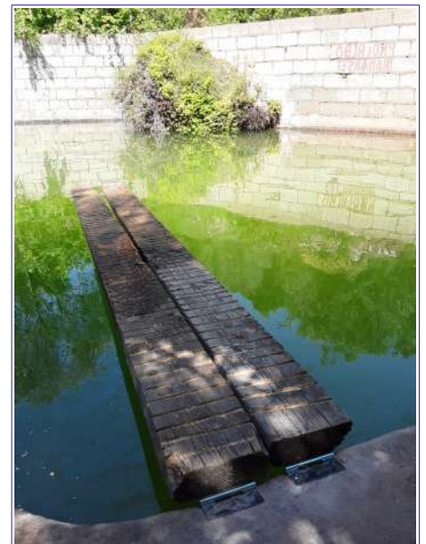
Rampa de seguretat per a fauna (Serra)
