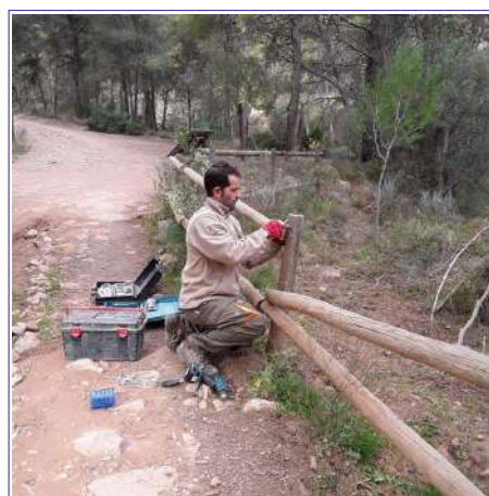
Reparació de la tanca del barranc de l'Arquet (Nàquera)
