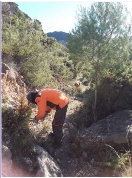
Treballs manuals de recuperació de la senda del barranc de la Fuente del Rincón (Marines)
