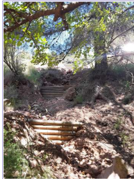
Aspecte del xaragall restaurat en la Misèria (Serra)
