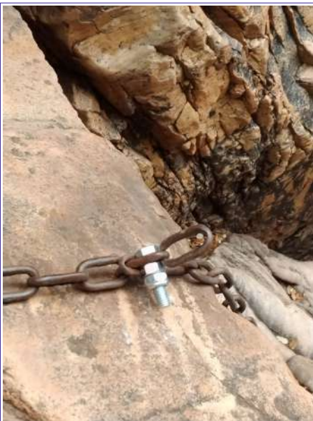
Reparació d'emergència de les cadenes del GR-10
