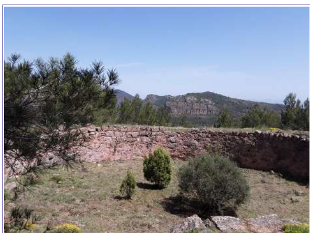
Desbrossament al ventisquer de Rebalsadors (Serra)
