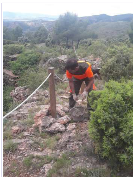
Reparació de la tanca de seguretat de la Cova Sacañé (Gátova)
