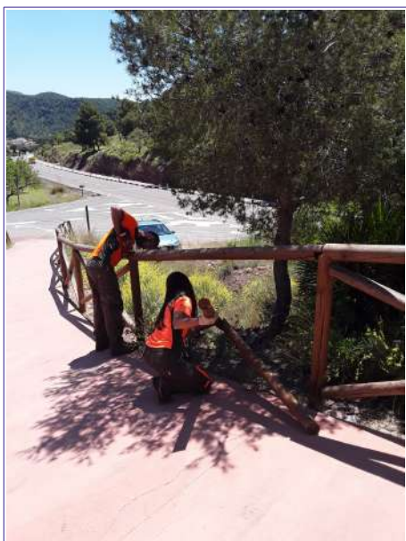
Reparació de la tanca de la pujada al Puntal dels llops (Olocau)
