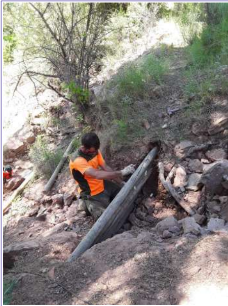
Treballs d'instal·lació del parapet de fusta (Serra)
