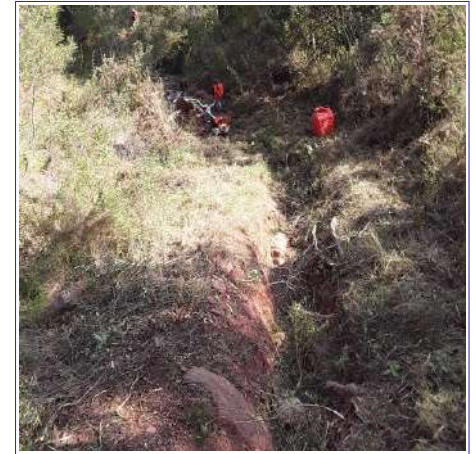
Desbrossament a la ruta blanca (Segorbe)
