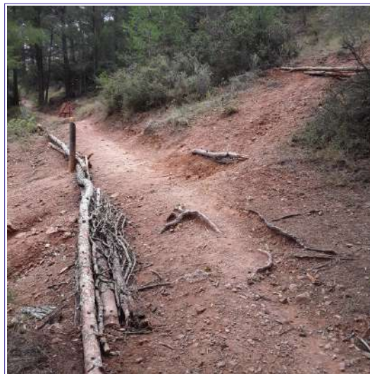
Estacada de llenya de pi per a evitar l'erosió en l'antic tallafocs de Banyet (Serra)
