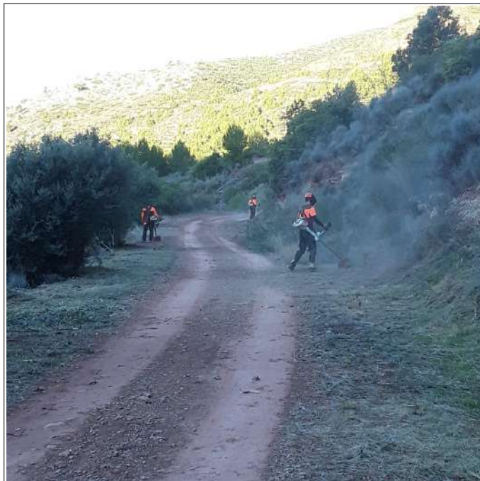
Desbrossament dels marges dels camins
