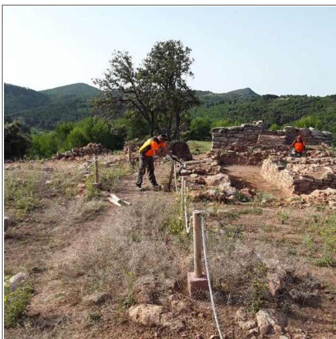
Col·locació de la tanca al camí
