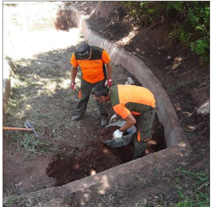
Treballs de buidatge de bassa.
