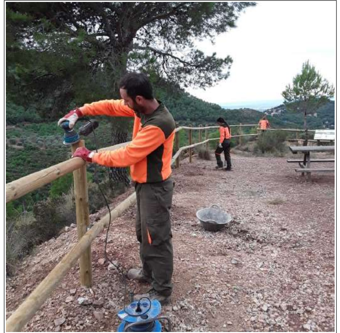
Reparació Mirador Fenassar (Nàquera)
