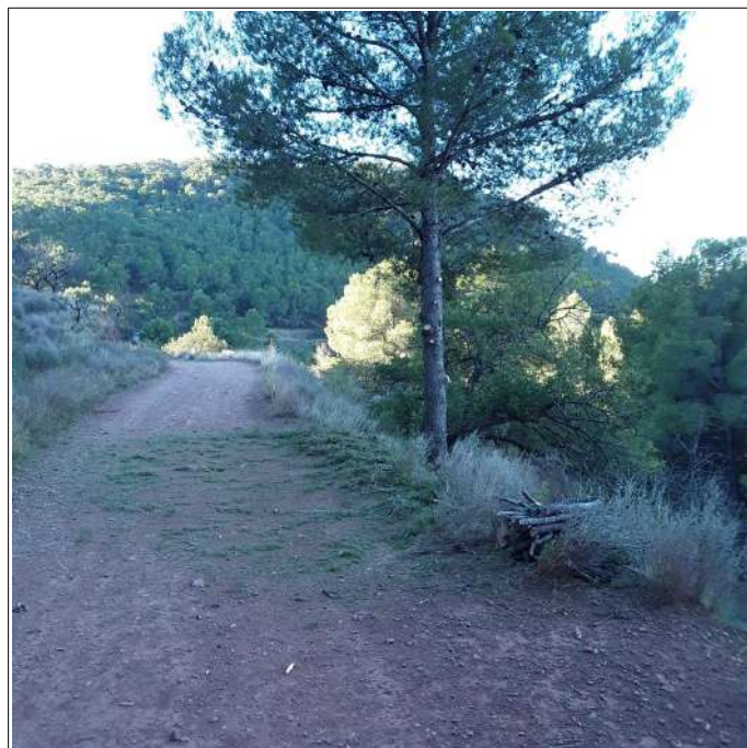
Aspecte després dels treballs
