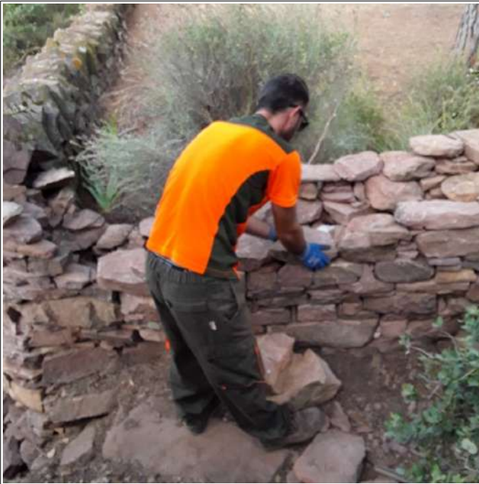
Reconstrucció muret ruta El Garbí
