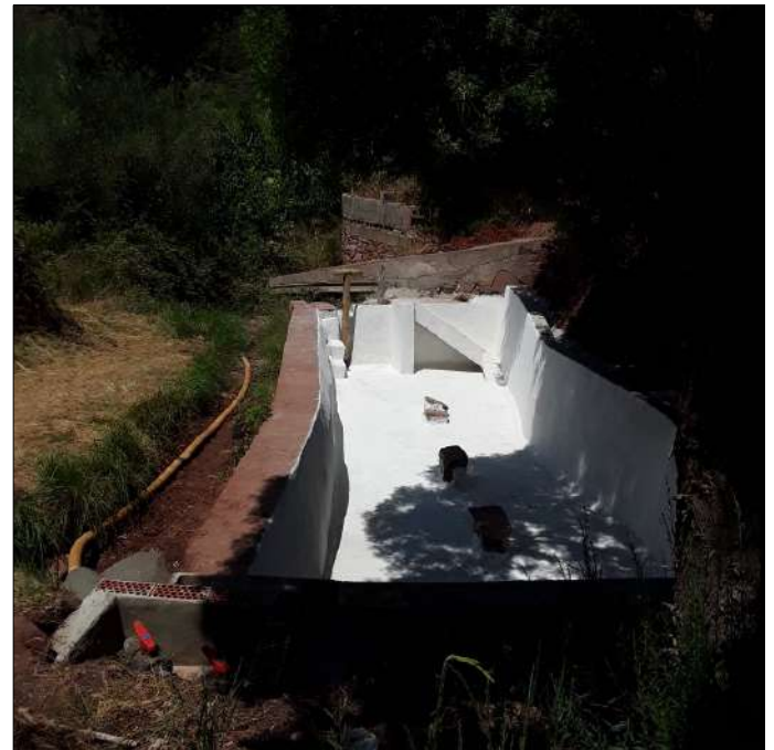
Estat final de la bassa.
