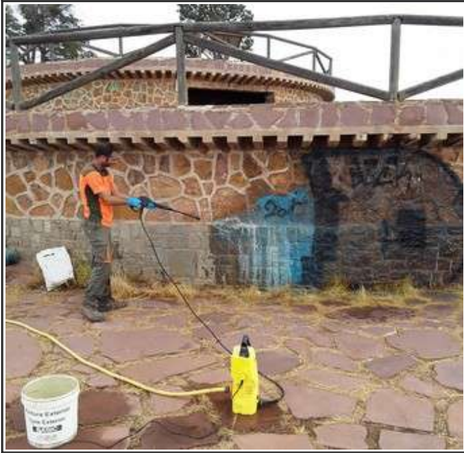
Eliminació de grafitis al Mirador de Rebalsadors (Serra)
