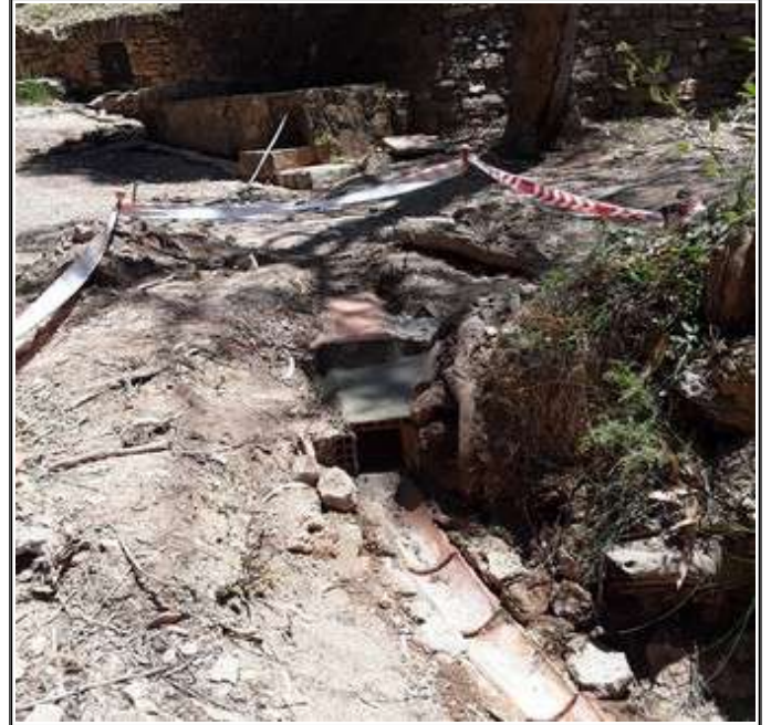
Reparacions en la canalització de la Font del Marge (Serra)
