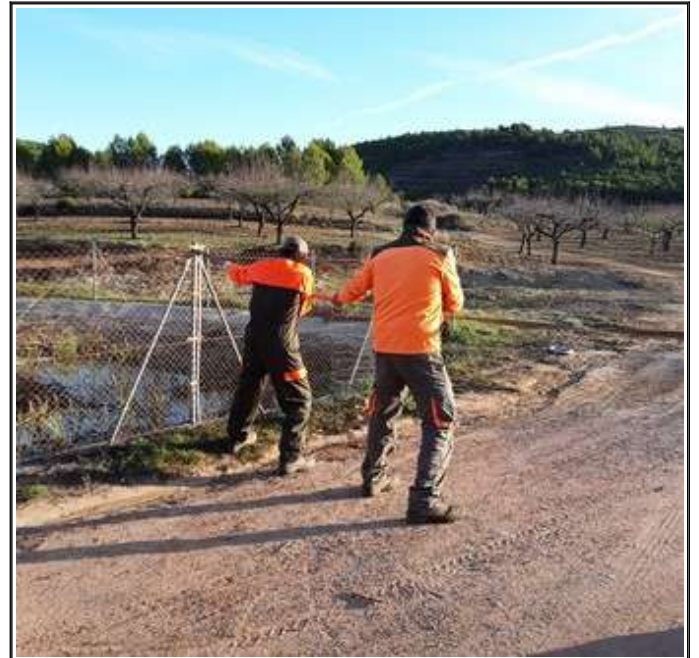
Reparació de la tanca metàl·lica de la bassa del Torrejón (Altura)
