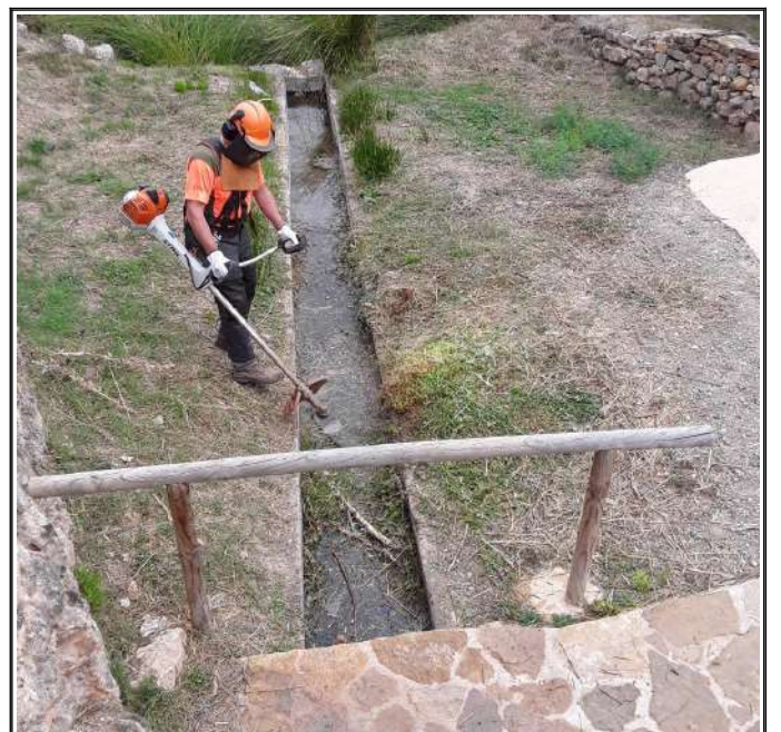
Desbrossament a la Fuente del Pozuelo (Altura)
