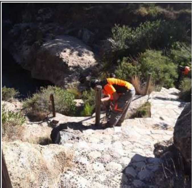
Manteniment dels pals de la tanca de les escales de Los Pocicos (Altura)
