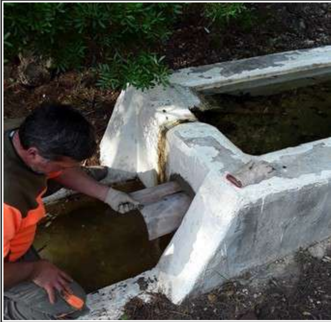
Reparació de conduccions a la Font del Comte (Algimia d'Alfara)
