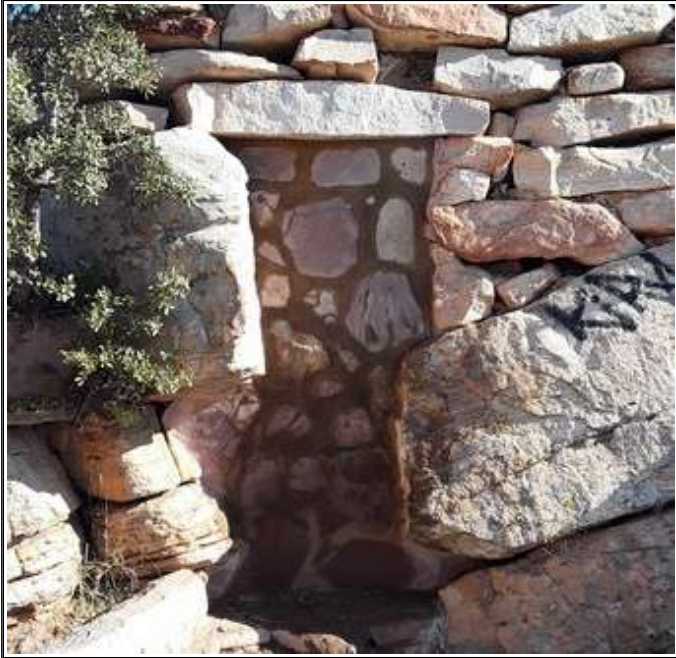
Porta del refugi del mirador del Garbí (Estivella)
