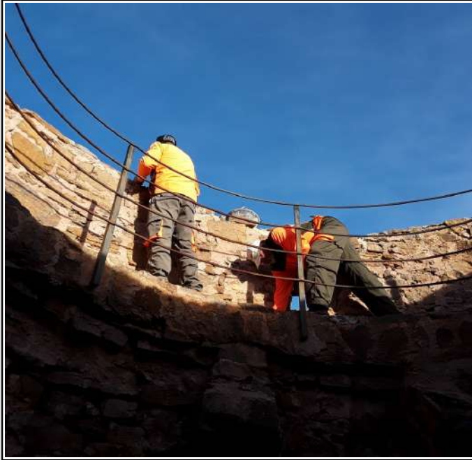
Treballs de reparació al Molino Iranzo (Gàtova)
