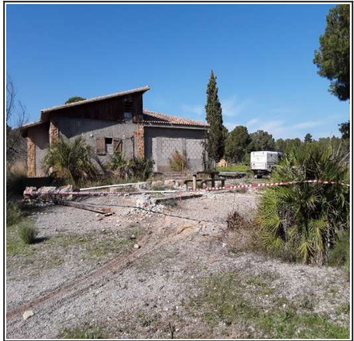
Eliminació de construccions de formigó i retirada d'escombraires i pedres al Pla de Lluc (Serra)
