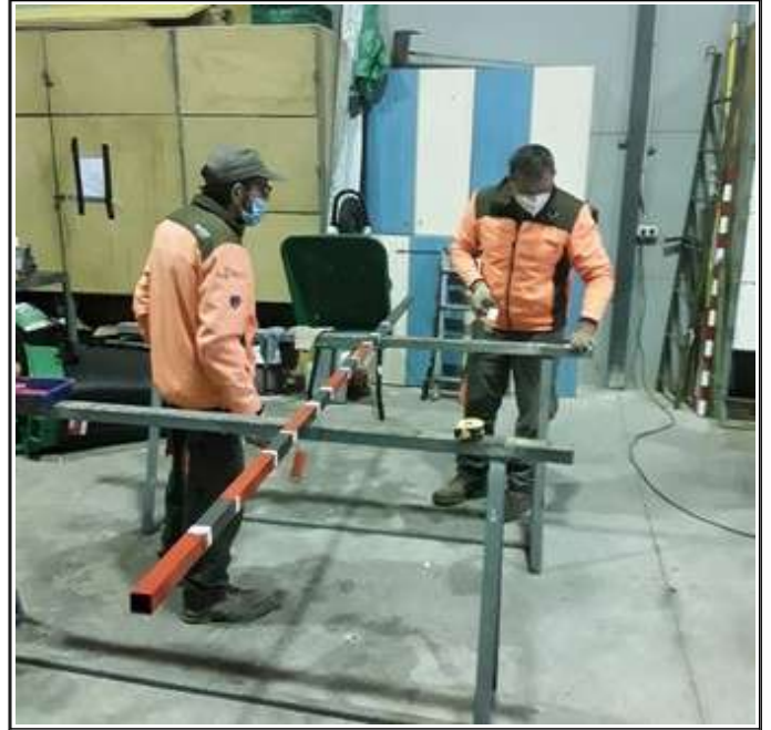
Construcció dels mesuradors per a les Llacunes de Segorbe
