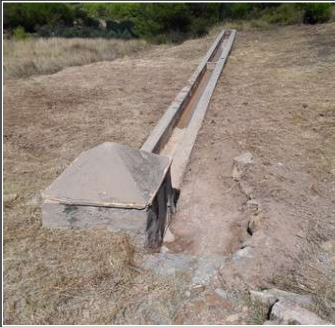
Neteja i condicionament de l'abeurador de la bassa del Torrejón (Altura)
