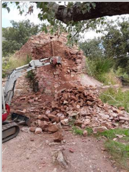
Demolició de la part danyada per perill de desprendiments.
