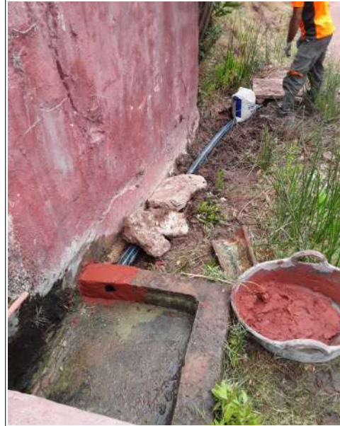
Font del Berro: canalització de sobrants.
