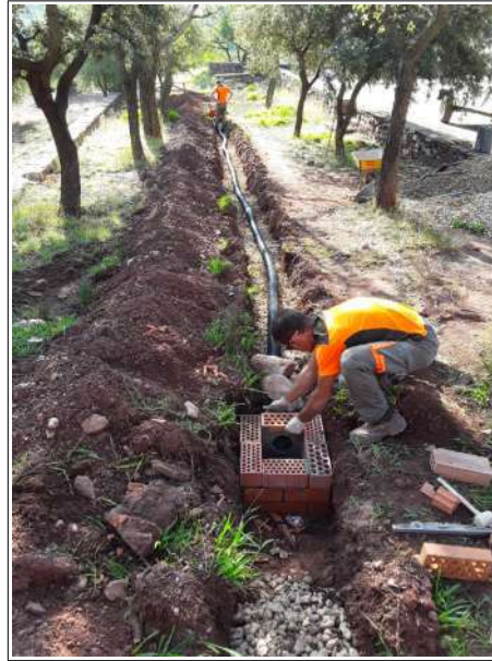
Canalització del sobrant per a evitar embassaments en bancals veïns.
