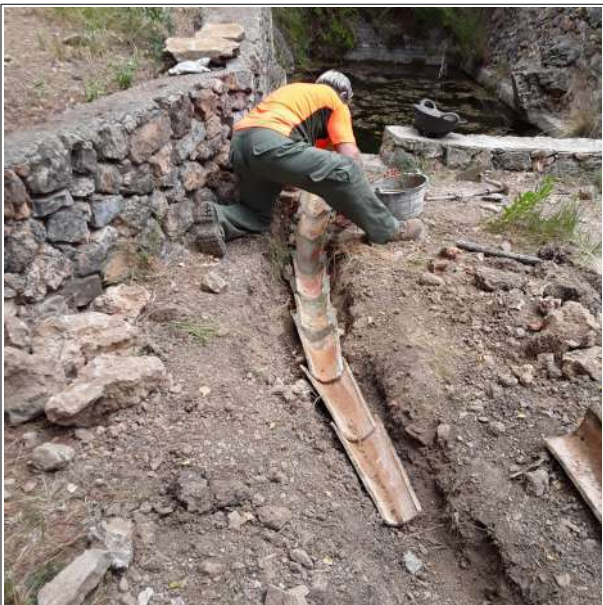
Font del Compte: manteniment i reparació de trams.
