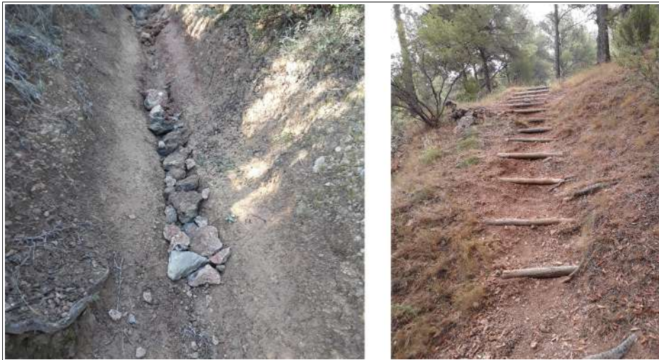
Diferents tècniques de reparació del ferm en senders.
