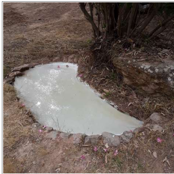
Reparació de la bassa del sobrant de la font.
