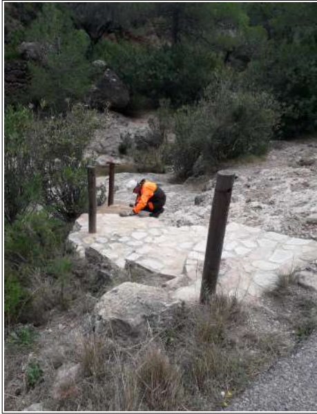
Reparació de les escales en Los Pocicos.
