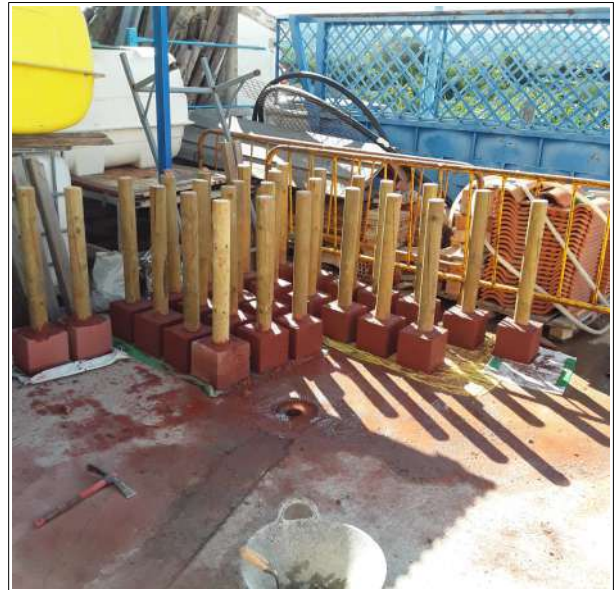
Postes amb base fabricada a propòsit en el taller.
