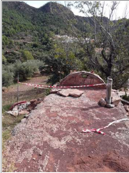
Construcció d'un accés als dipòsits.
