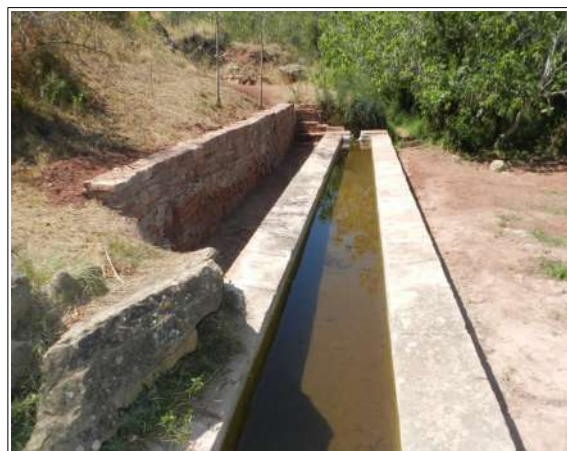
Final de l'actuació on s'observa el mur a l'esquerra, el buidatge de terra en la zona on es posaven les persones per a llavar i la reposició de la barana.
