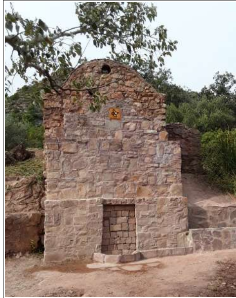
Després de l'actuació a falta dels taulellets.
