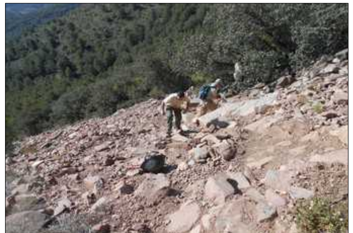
GR 10 en Segart. Minimització dels efectes de l'erosió en el sender.
