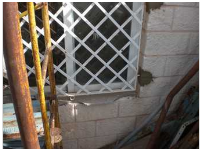
Reparació reixa en magatzem d'Altura.
