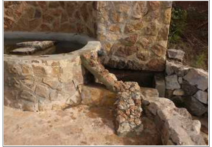
Font del Poll després de la construcció de les rampes per a la fauna.
