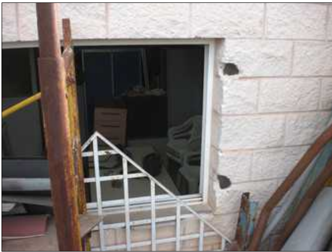
Reparació reixa en magatzem d'Altura.
