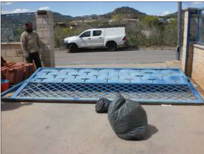
Reparació porta en magatzem d'Altura.
