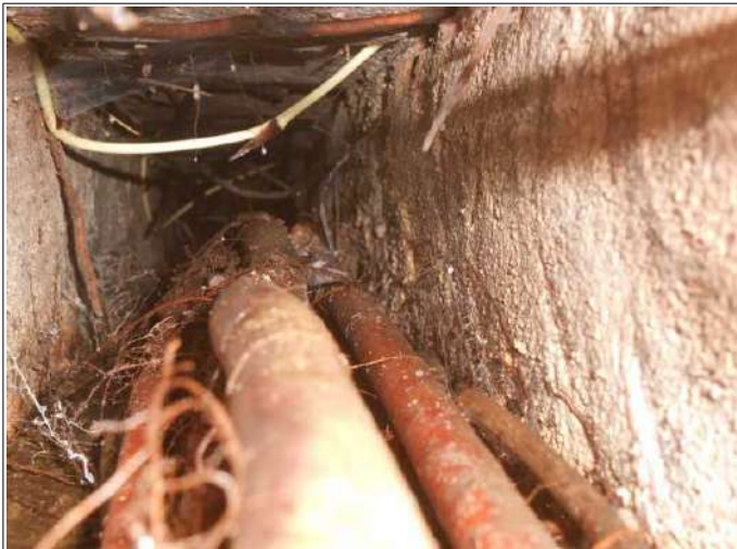
De tall de les arrels dins de la canalització de la font de Potrillos.
