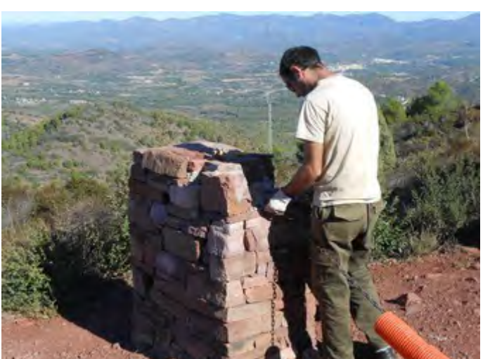
Muret en la tanca d'accés a l'àrea recreativa del Garbí, Estivella.
