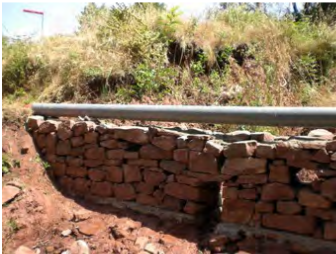
Reparació de la solsidea en la canalització que alimenta l'abeurador
