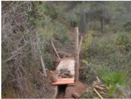
Construcción de un puentecito para pasar por encima de la acequia en un punto donde desaparece la senda paralela a la misma
