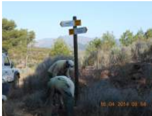
Recolocación de postes de señales del PR-CV 329 en Nàquera
