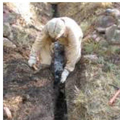
Limpeja i desbroce de l'acequia.
