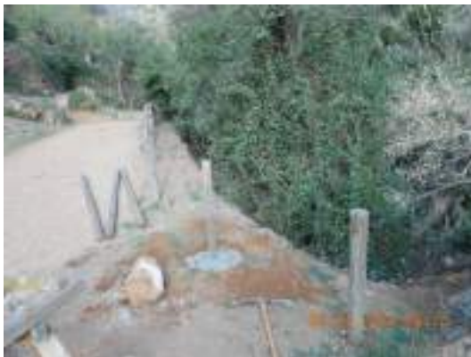
Reparación de valla y desbroce de la Font del Marianet
