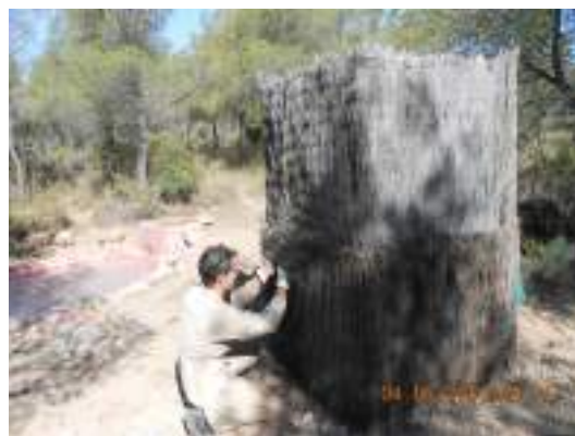
Balsa alrededores del Llano de Lucas (Serra): Construcción, reparación, limpieza y llenado.
