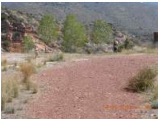
Desbroce del Área Recreativa de Pi del Salt
