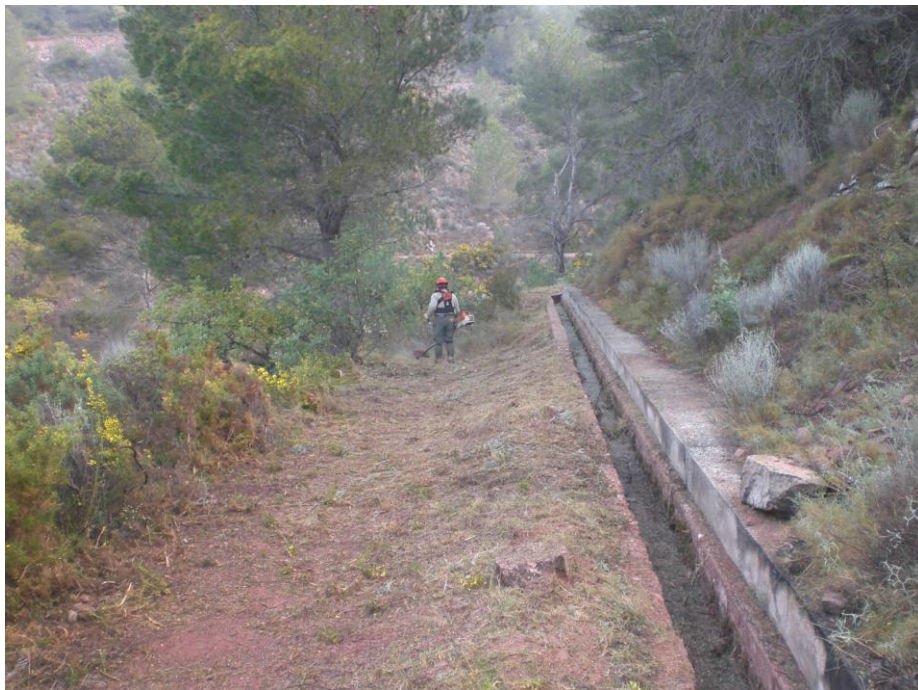
Limpieza y adecuación de sistemas de riego tradicionales
