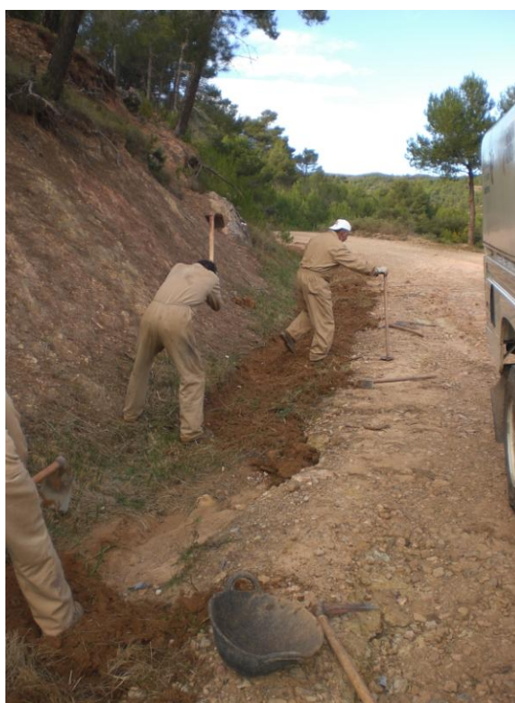
Mantenimiento de cunetas
