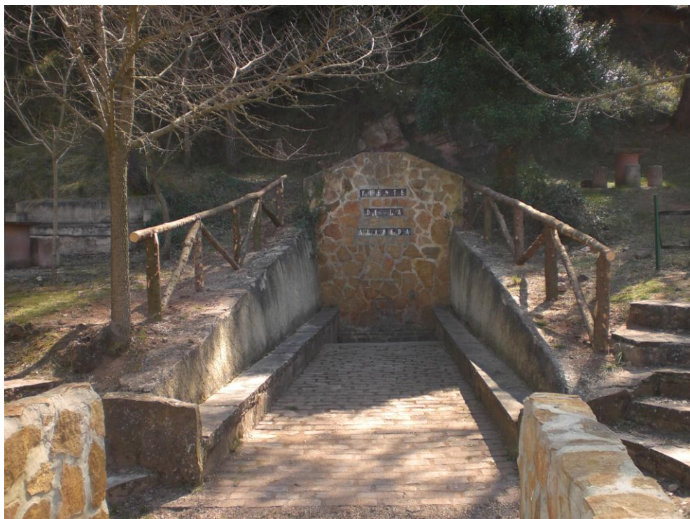
Trabajos de mejora seguridad en AR Fuente de La Alameda (Gátova)
