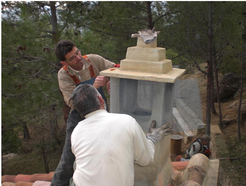
Adecuación de paellers. Colocación de matachispas
