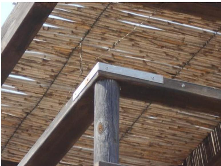
**ILUSTRACIÓN 58: REFORZAMIENTO PARTE SUPERIOR DE LA TORRE EL ALTILLO**
