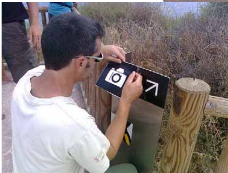
Fotografía 3 Trabajos de mantenimiento de instalaciones y señalética
