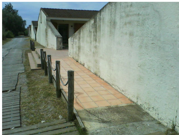
Rampa de acceso donde comenzará la serie de huellas.
