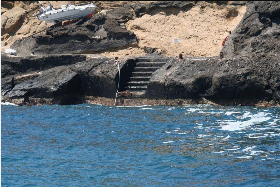
Figura 17. Escala de puerto Tofiño y rampa aledaña.
