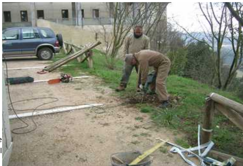
Reparación de la barandilla de madera en el área del aparcamiento
