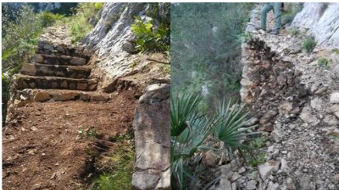
Figura 39: Comparativa entre l'actuació finalitzada i el despreniment previ
