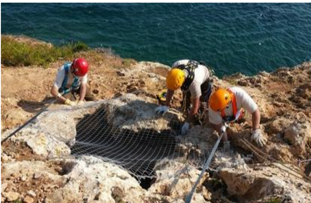
Figura 38: Actuació de tancament dels forats superiors de la Cova Tallada
