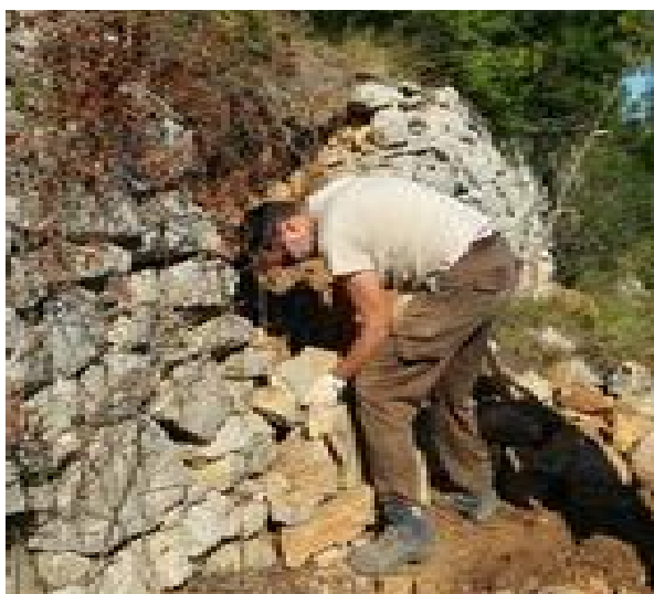
Figura 32: Reparació de mur al Racó Fosc
