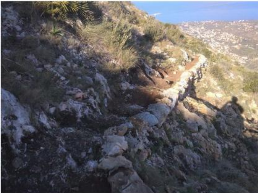
Figura 33: Adequació de la senda del Cim. Abans i després dels treballs. Foto: GEA AMBIENTAL
