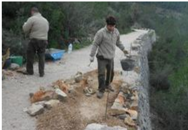
Figura 21: Treballs de reparació d'ampits
