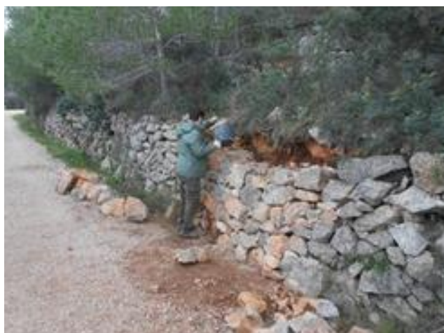
Figura 22: Treballs de reparació del mur de contenció
