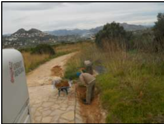
Figura 13: Mantenimiento de la arqueta del depósito de la Punta de Benimaquia
