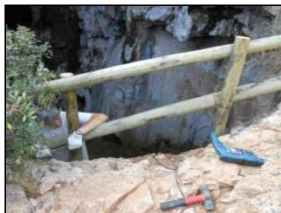
Figura 31: Tramo de talanquera instalado en la sima principal de la Cova del Gamell
