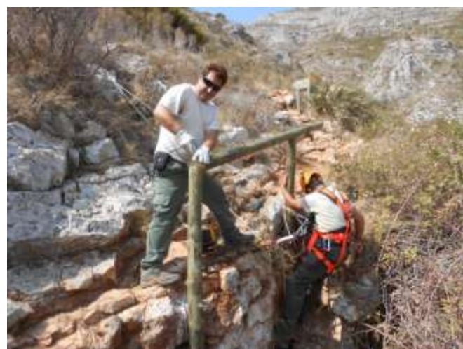
Figura 21: Infraestructuras de seguridad en la Cova del Gamell
