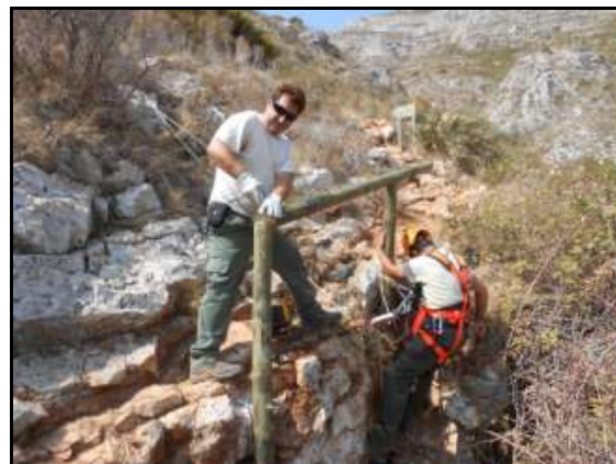
Figura 32: Trabajos de instalación de talanquera en la entrada secundaria de la Cova del Gamell
