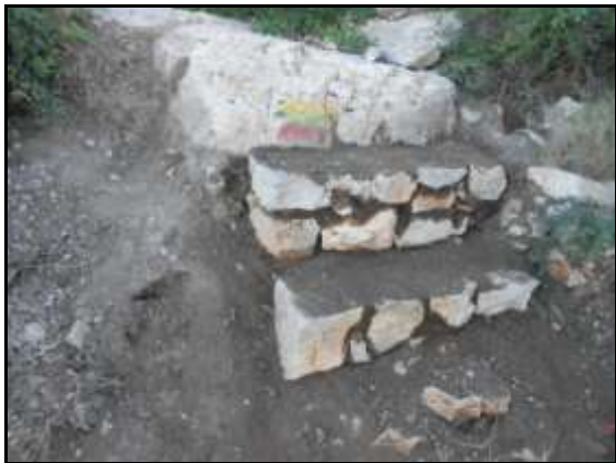
Figura 28: Trabajos de reparación de la senda de la Cova de l'Aigua (antes y después)
