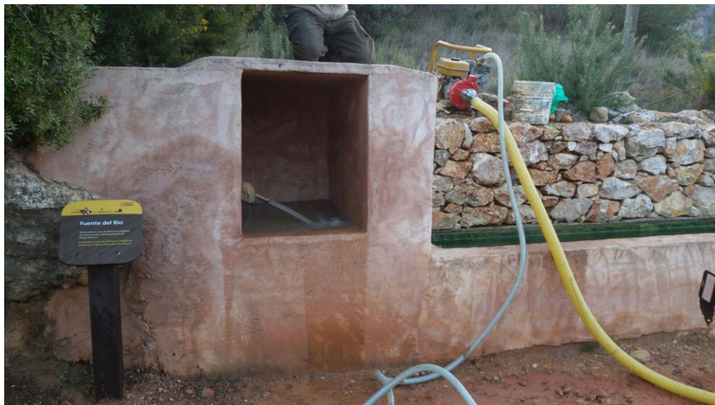
Actuaciones en Fuente del Río en Chera.
