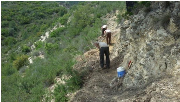
Trabajos de adecuación de sendas
