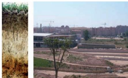
**R1** Durante las operaciones de excavación, se recomienda retirar la **capa de suelo fértil** afectada por el proceso constructivo y almacenarla de forma adecuada (en pilas no superiores a 1,5 metros de altura, y sin compactar) a fin de poder ser reutilizada en las zonas a ajardinar posteriormente.
