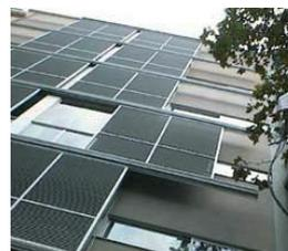
**R1** Proteger las fachadas (especialmente la oeste) de la radiación solar excesiva mediante elementos protectores solares:
