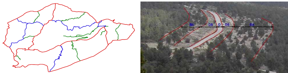
Figura 86. Cortafuegos PN Font Roja. D → Decapado, DS → Desbroce Selectivo, BA → Banda Auxiliar.
