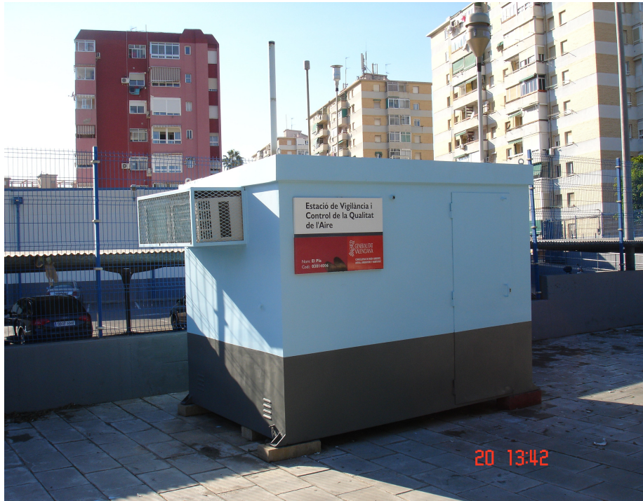
Foto: Estación de ALACANT-EL PLÀ
