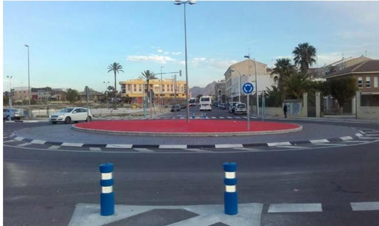
*Ampliación de rotonda en Novelda con recalanzado de carriles de acceso, y con un diseño que evita que la invasión de la isleta central por pérdida del control de un vehículo pueda dar lugar a un accidente grave.*
