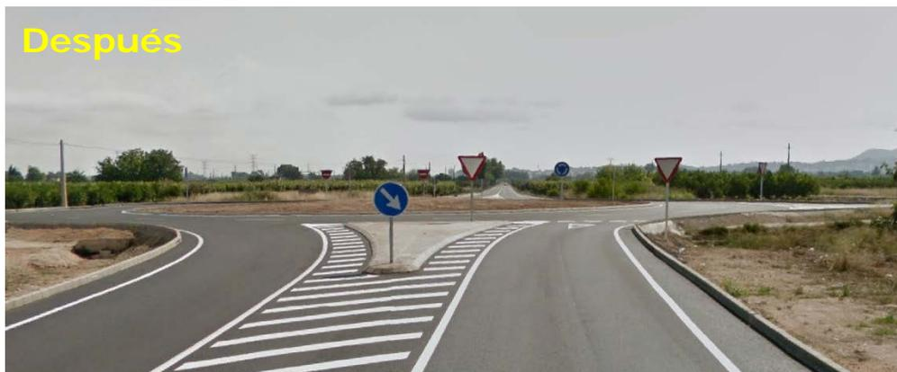
*En esta intersección se producían accidentes muy graves debido al intenso tráfico de cruce e incorporación a la carretera CV-550 con distancias de visibilidad reducidas. La construcción de esta glorieta permite que todos los movimientos de conexión de los caminos colindantes con la carretera CV-550 se hagan en condiciones de seguridad.*
