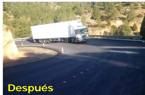
*Tramo de carretera con plataforma estricta fuertemente condicionada por la orografía del terreno y presencia de vehículos pesados. La actuación comprende ampliación de plataforma, mejora de curvas y mallas de protección para evitar caída de piedras a la calzada.*
