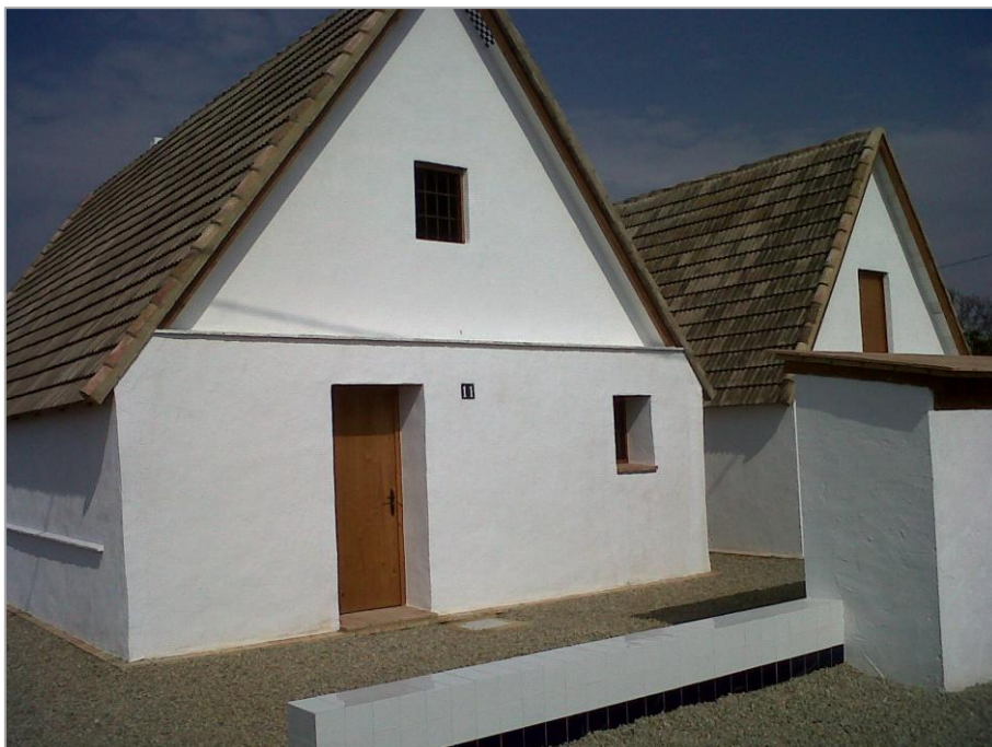
Figura 6. Traslado y Rehabilitación de las Barracas de Roca finalizado
