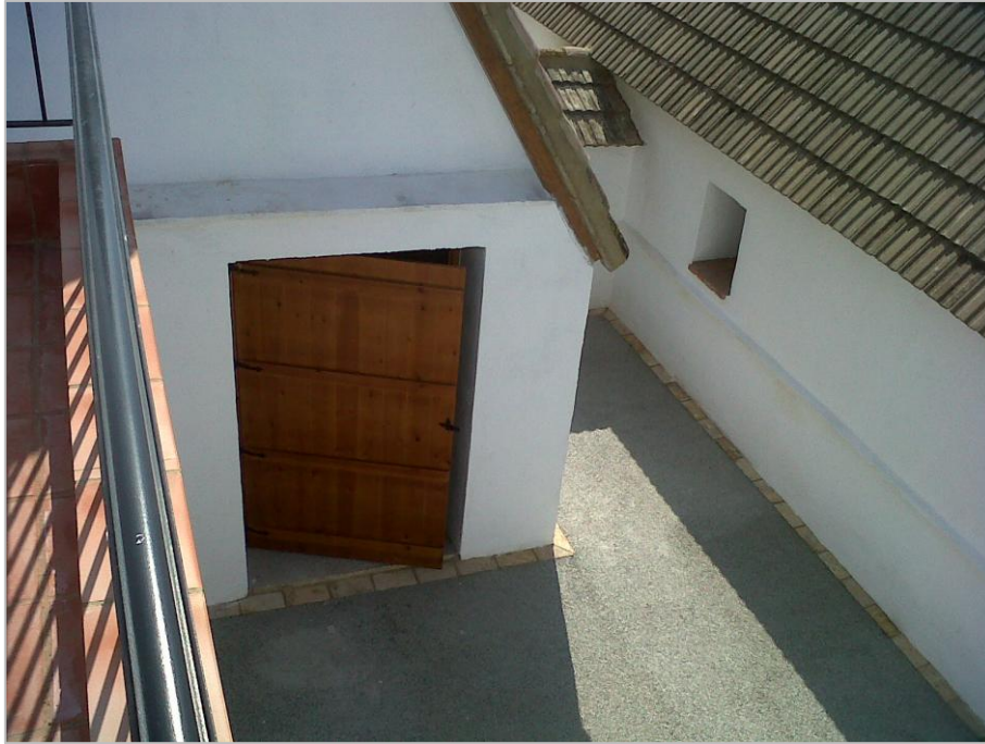
Figura 3. Traslado y Rehabilitación de las Barracas de Roca finalizado
