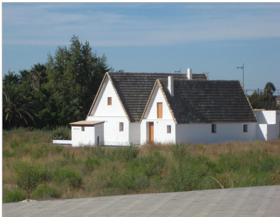
Figura 5. Traslado y Rehabilitación de las Barracas de Roca finalizado
