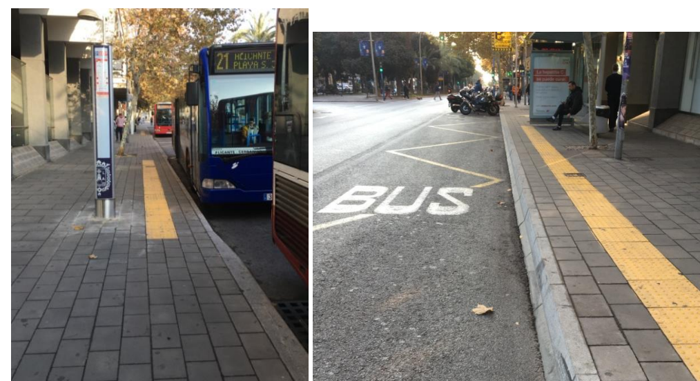
Exemple de parada accessible amb vorada accessible
