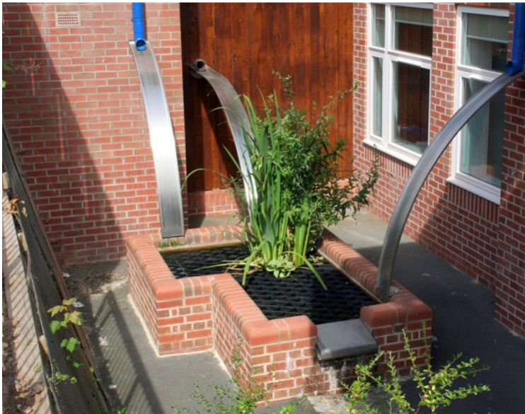
Fig 5: ejemplo de colector de pluviales en el Fort Royal School, Reino Unido Fuente: http://www.robertbrayassociates.co.uk/what-are-suds/
