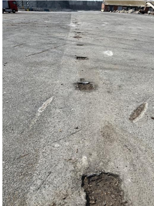
Figura 4. Estado actual imbornales
