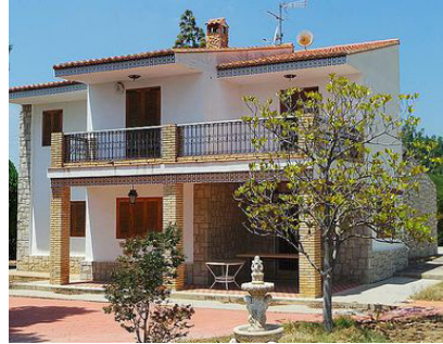
Solado y camino libre de vegetación alrededor de la vivienda
